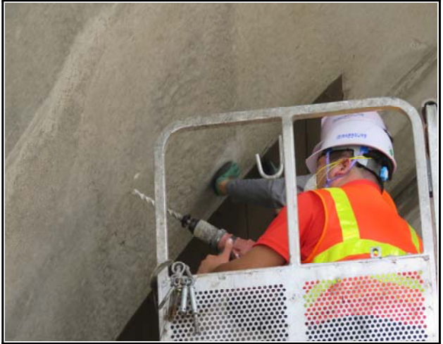
내 용 고소차를 이용한 내구성조사
