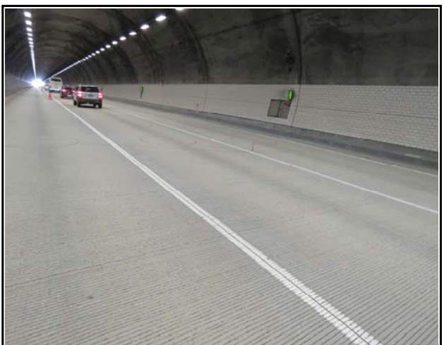
내 용 바닥부 전경
