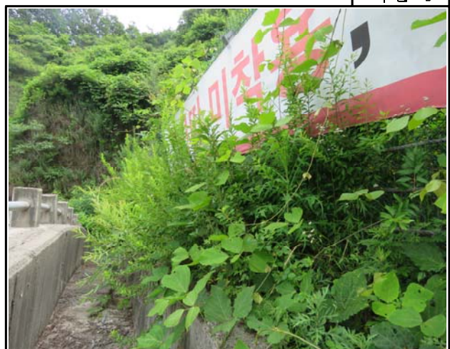
내 용 종점 갱구부 상부 전경
