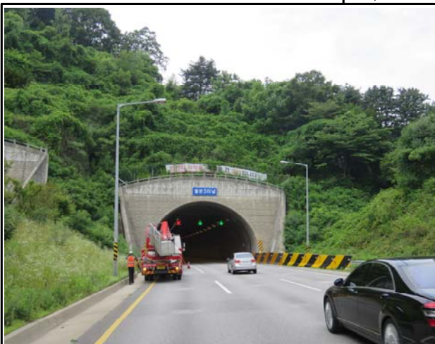
내 용 종점부 사면 전경
