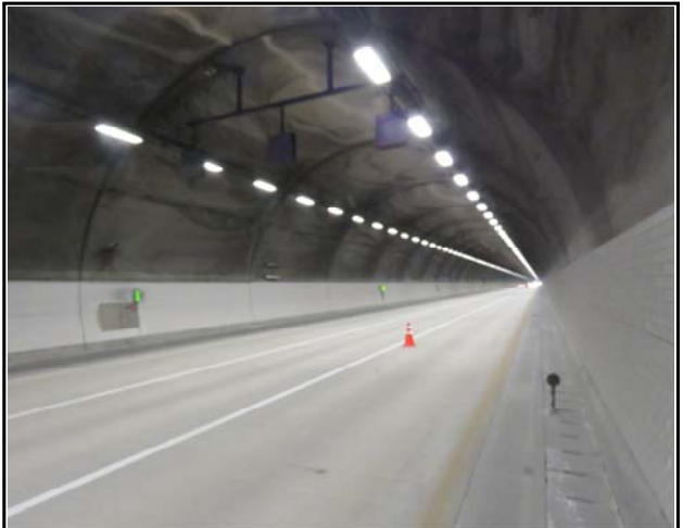
내 용 터널 내부전경
