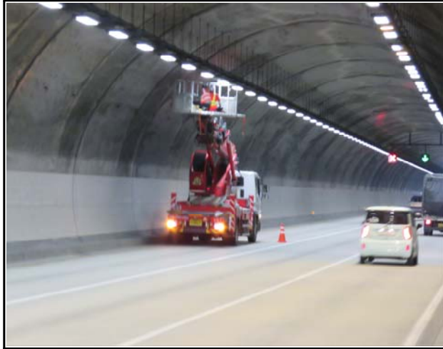
내 용 고소차를 이용한 접근조사 전경
